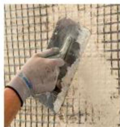
Ugradnja FRCM sustava
