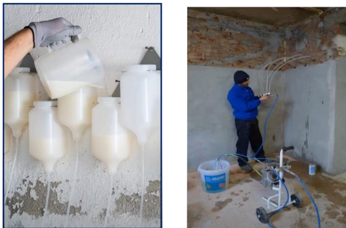
Slika 42. Izvedba kemijskog prekida kapilarne vlage
