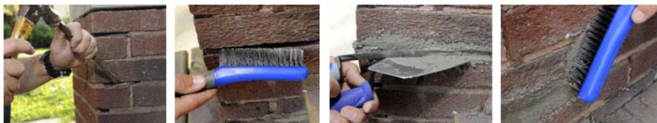
Slika 23. Djelomična zamjena morta u sljubnicama
