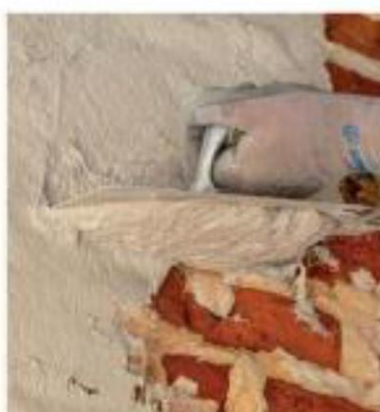
Žbukanje reparaturnim mortom
