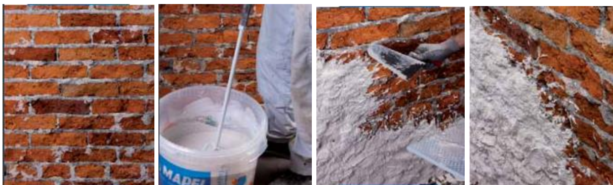
Slika 43. Proces nanošenja temeljne žbuke
