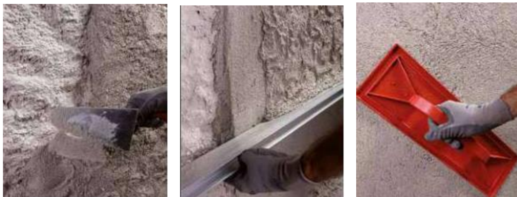
Slika 44. Nanošenje isušujuće žbuke preko temeljne žbuke
