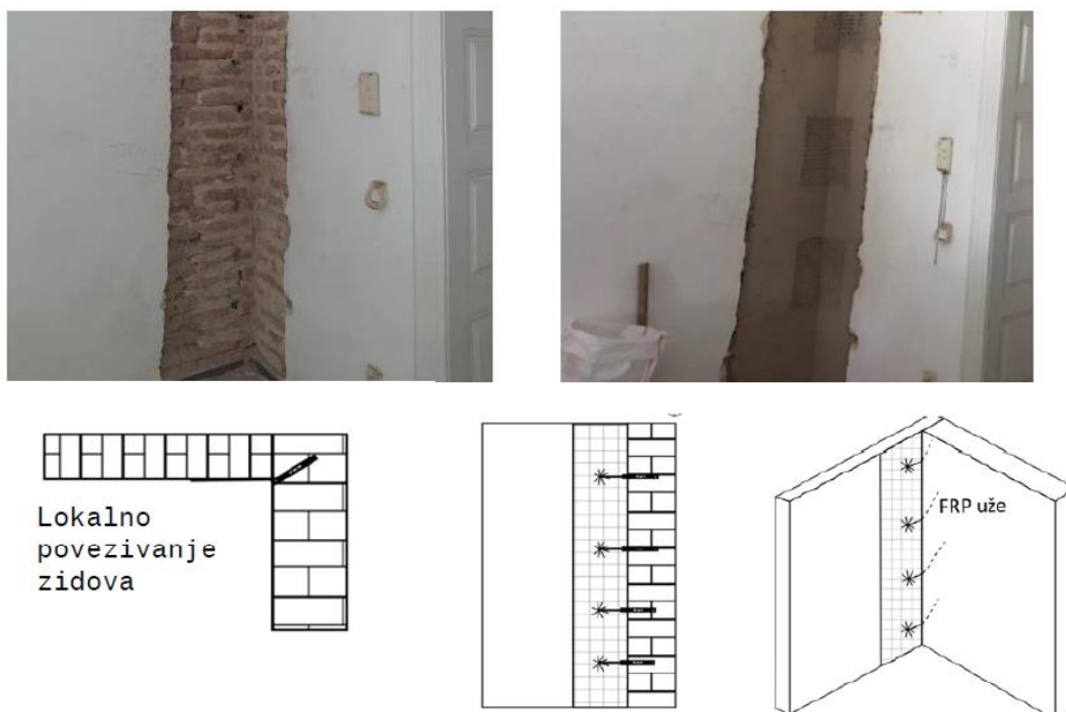
Slika 27. Sanacija spoja nosivih zidova
