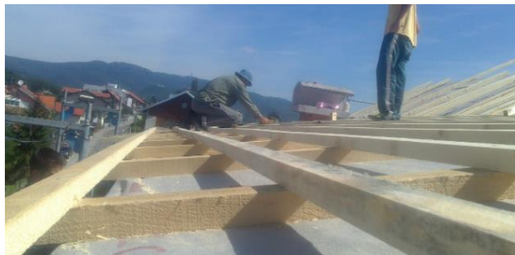
Slika 40. Letve i kontraletve na foliji
